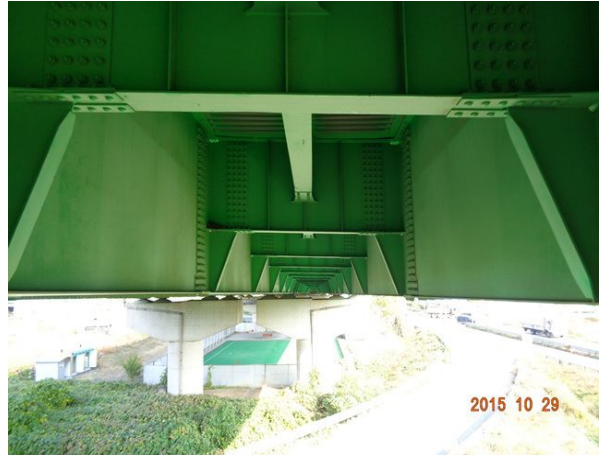
바닥판 및 거더 전경
