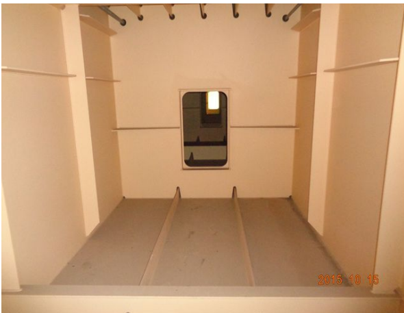
거더 내부 전경
